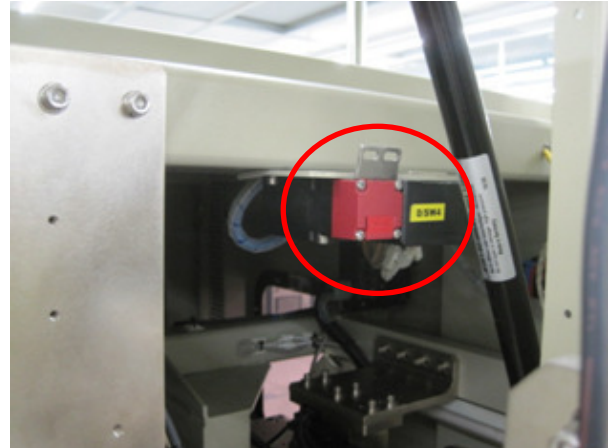
↑ 設備機台設置安全連鎖裝置並保持功能
