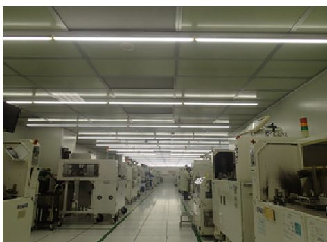
無塵室更換 LED 燈管
