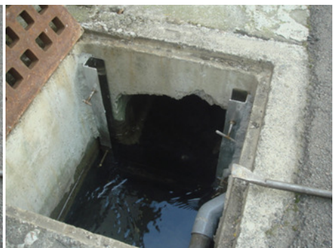
↑ 雨水溝設置水閘門水質異常時回收處理 ↑
