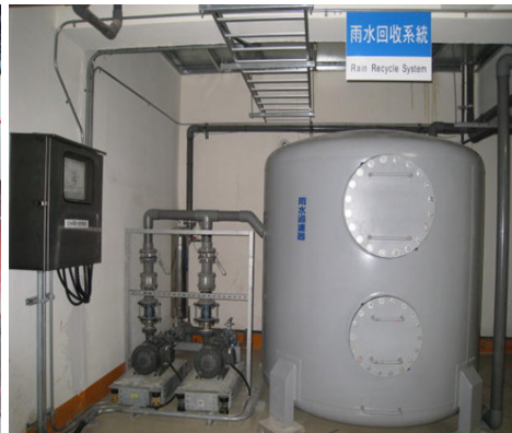
↑ 各廠建置雨水回收系統
