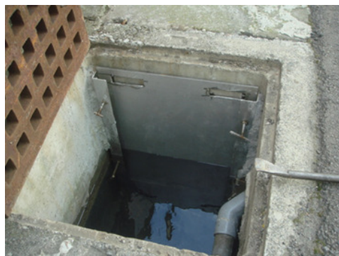
↑ 雨水溝設置水閘門水質異常時回收處理 ↑
