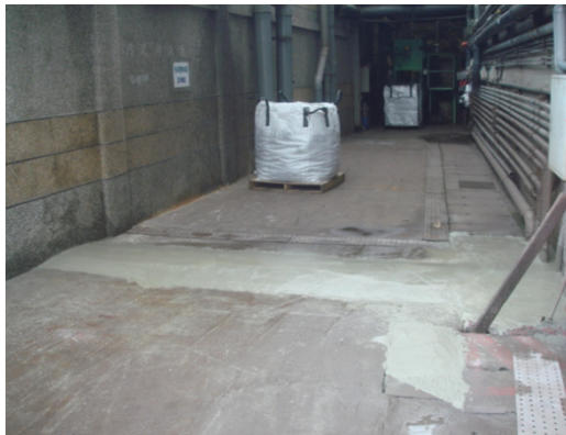
↑ 污泥儲存區設置導水墩
