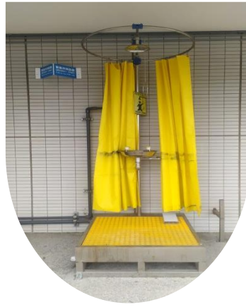
水處理區緊急沖淋設備
