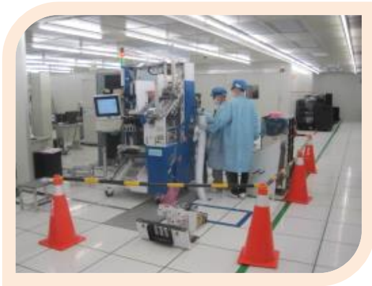
↑ 建立設備保養現場管制要求
